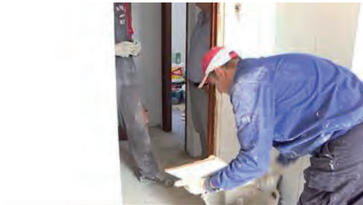
Jóvenes de IMENA (empresa de inserción laboral del Hogar de San José) reparando una vivienda para su posterior adjudicación. VIPASA reserva un porcentaje del contrato de mantenimiento y reparaciones a empresas de inserción.
